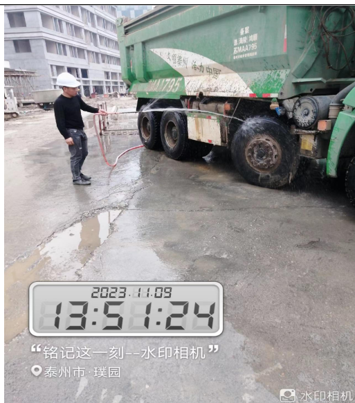
施工车辆冲洗
