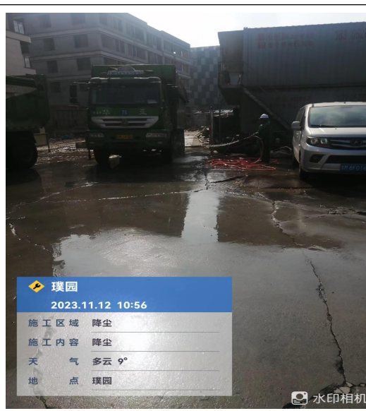
施工车辆冲洗
